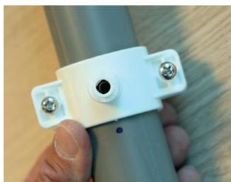
**7** Positionner le raccord collier d'évacuation sur la canalisation d'évacuation PVC de l'évier et pointer le trou à percer.
