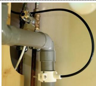
**10** Insérer le tubing noir dans le raccord collier d'évacuation
